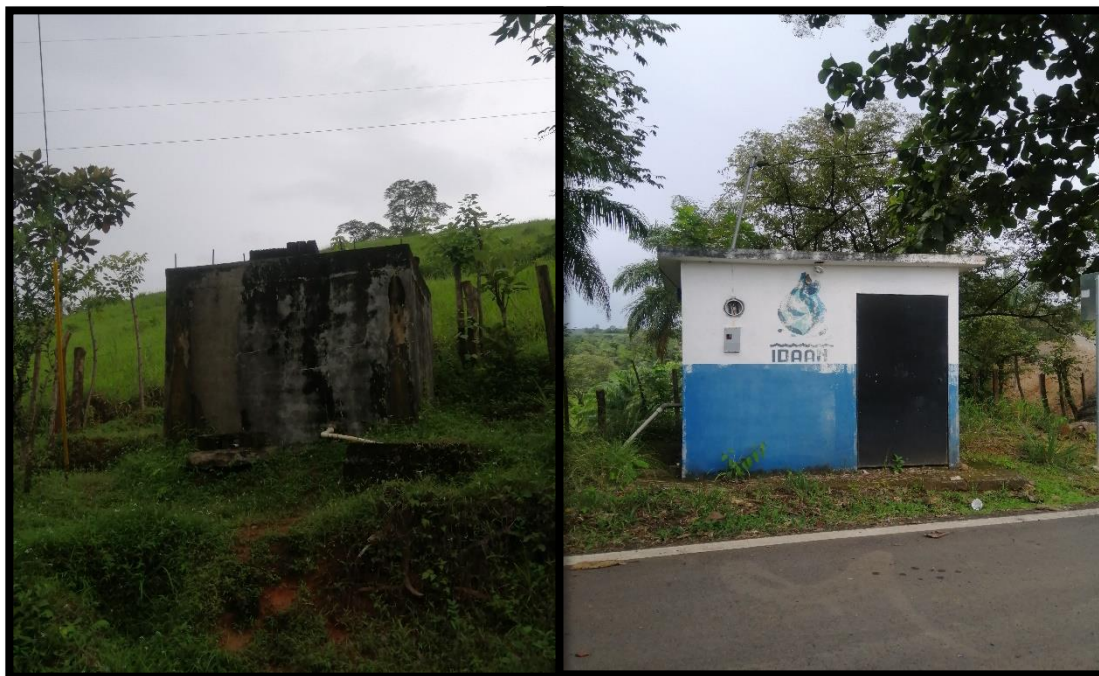
Acueducto de la comunidad del Suay en el Corregimiento de Ponuga
