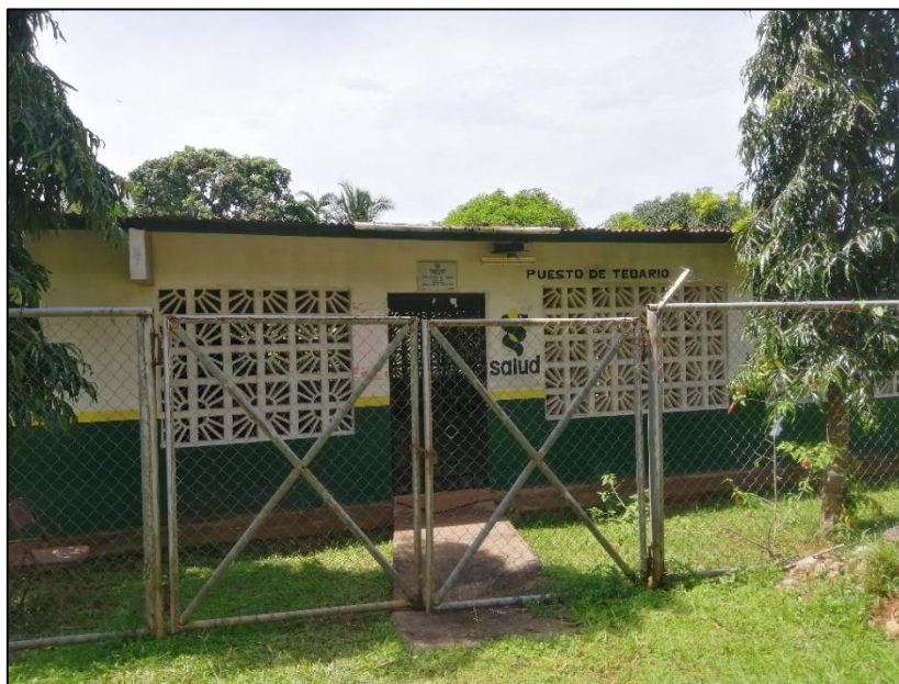
Figura 70. Puesto de Salud de Tebario
