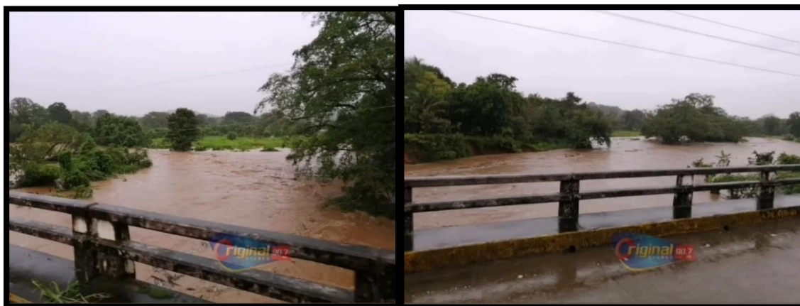
Figura 16. Puente del Río Suay.
