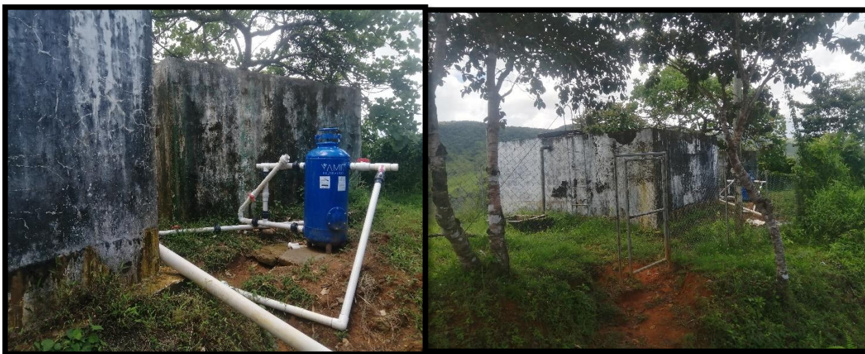
Tanque de almacenamiento del acueducto del Toro
